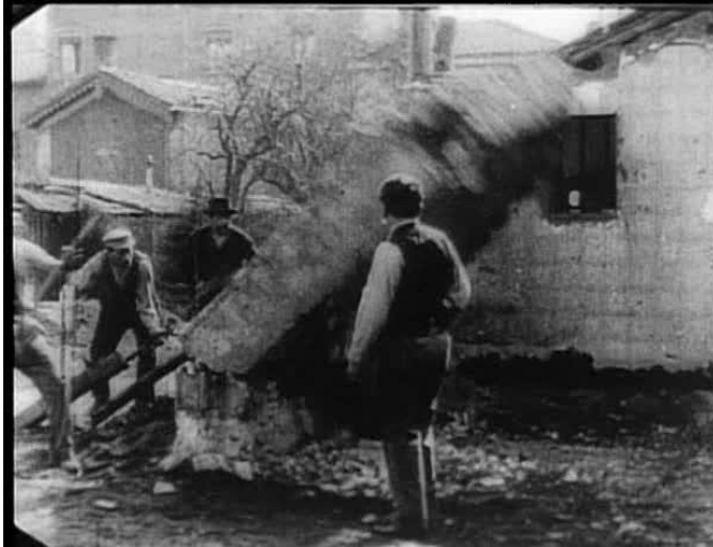
Bratři Lumièreové, Bourání zdi, 1896
