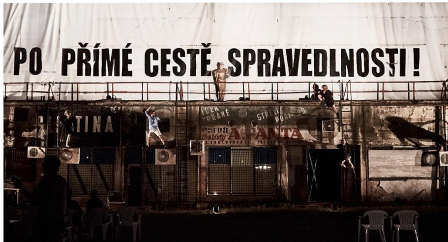
80, 81, 82 Proměna fasády Fuchsovy kavárny
