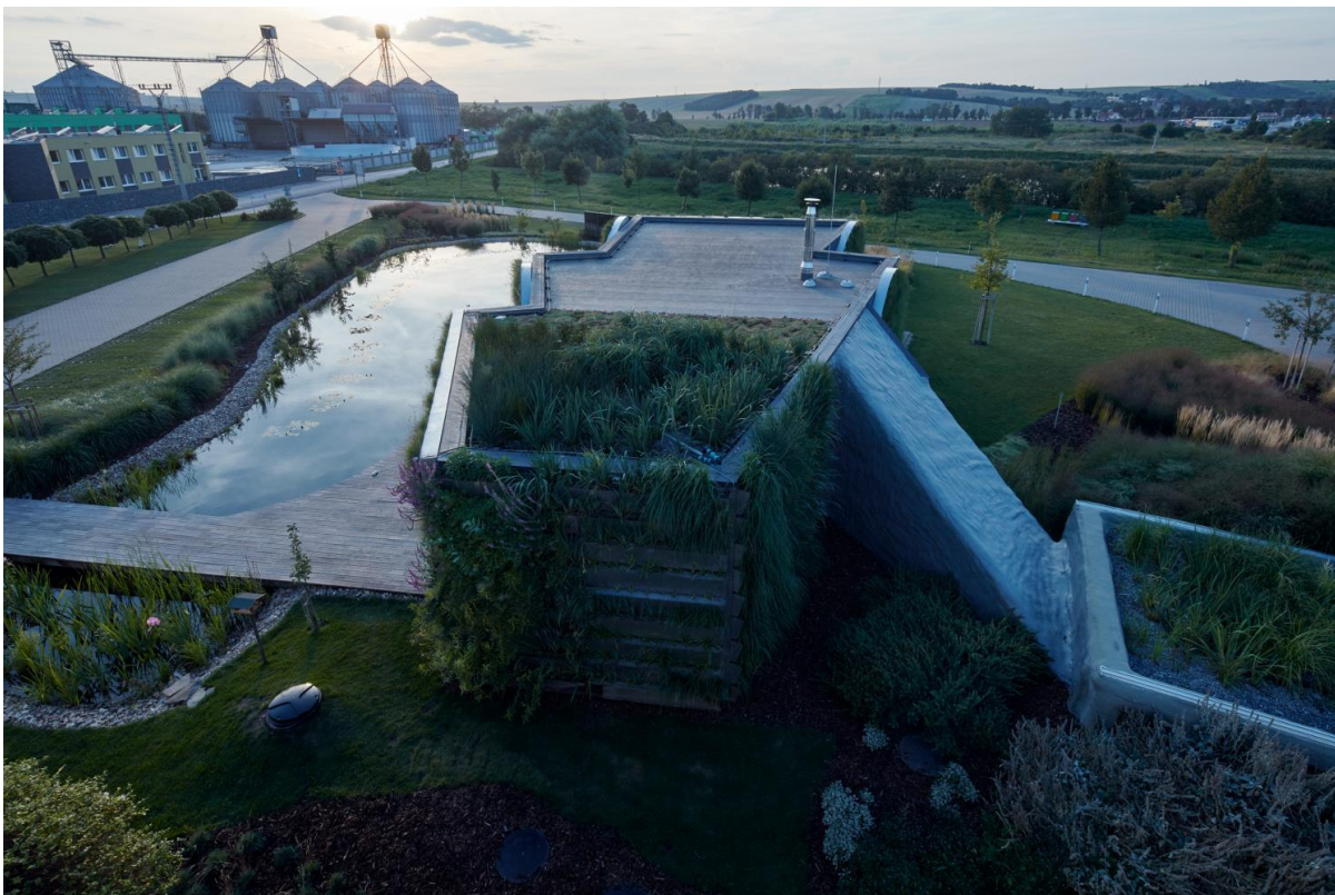
Obrázek č. 32: Dronová fotografie realizace LIKO-NOE arch. studia Fránek architects, foto BoysPlayNice
