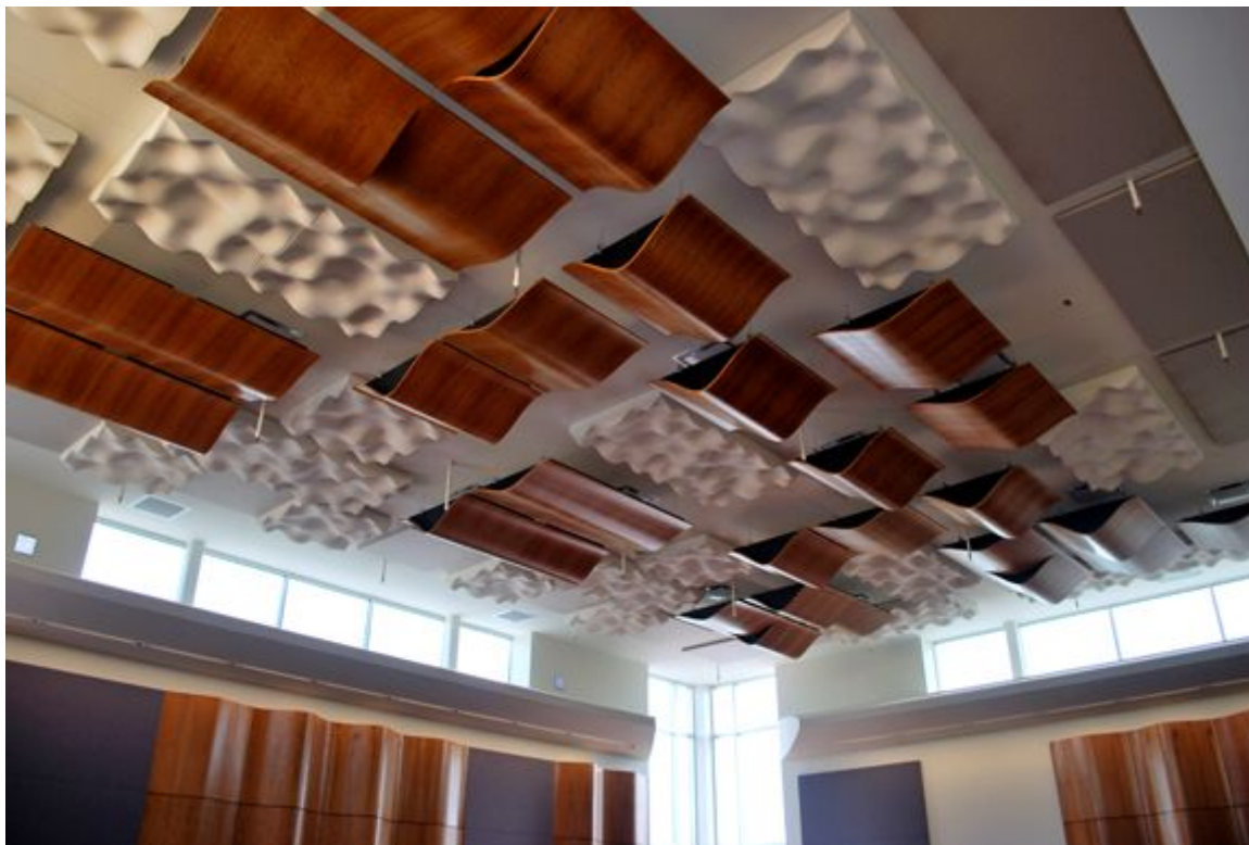
Obr. 15, příklad difuzních prvků; zdroj: http://www.totalvibrationsolutions.com/page/288/Diffusers.htm
