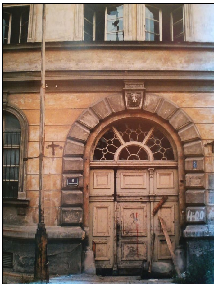
Příloha č. 2 - Vchod do budovy před rekonstrukcí
