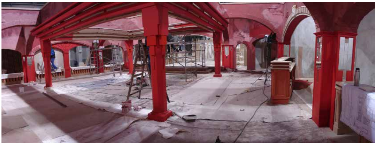
Le Gerny, stavba v ateliéru
