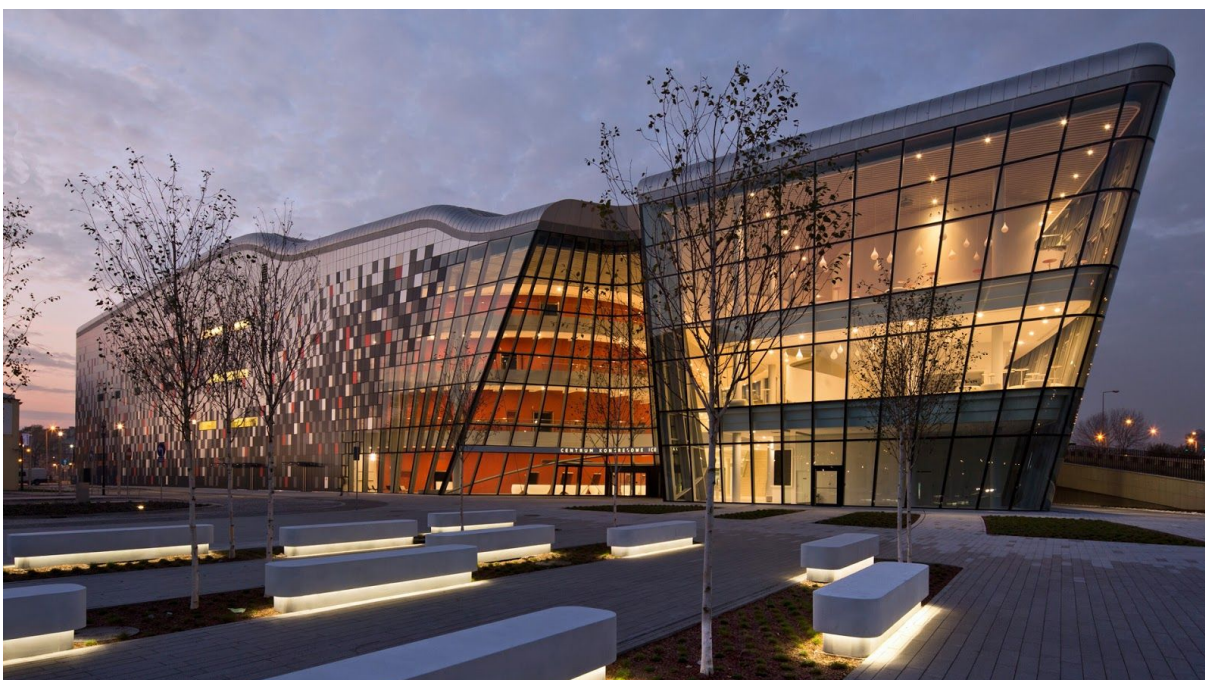
Obrázek č. 29: ICE Krakow, exteriér. 108
