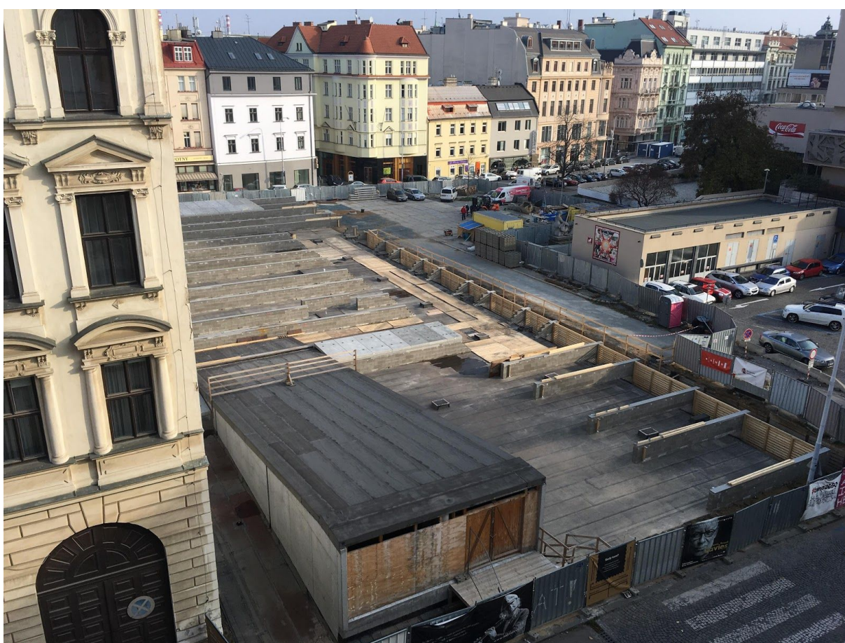
Obrázek č. 20: Lokalita budoucího Janáčkova kulturního centra po ukončení výstavby I. etapy (fotografie z r. 2018). 84
