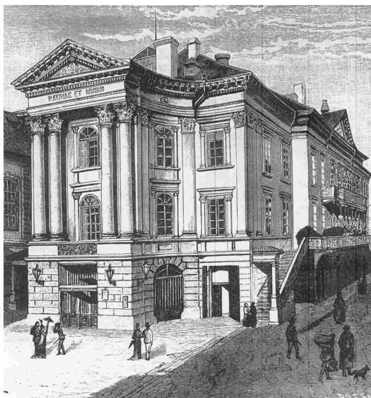
příloha č. 3 – oceloryt F. Barta zachycující Stavovské divadlo po přestavbě (1882), kdy byly z požárních důvodů zřízeny na bocích budovy zděné i litinové pavlače s vnějšími únikovými schodišti, z knihy „Stavovské divadlo – průvodce budovou“, publikace Národního divadla v Praze, Praha 1994
