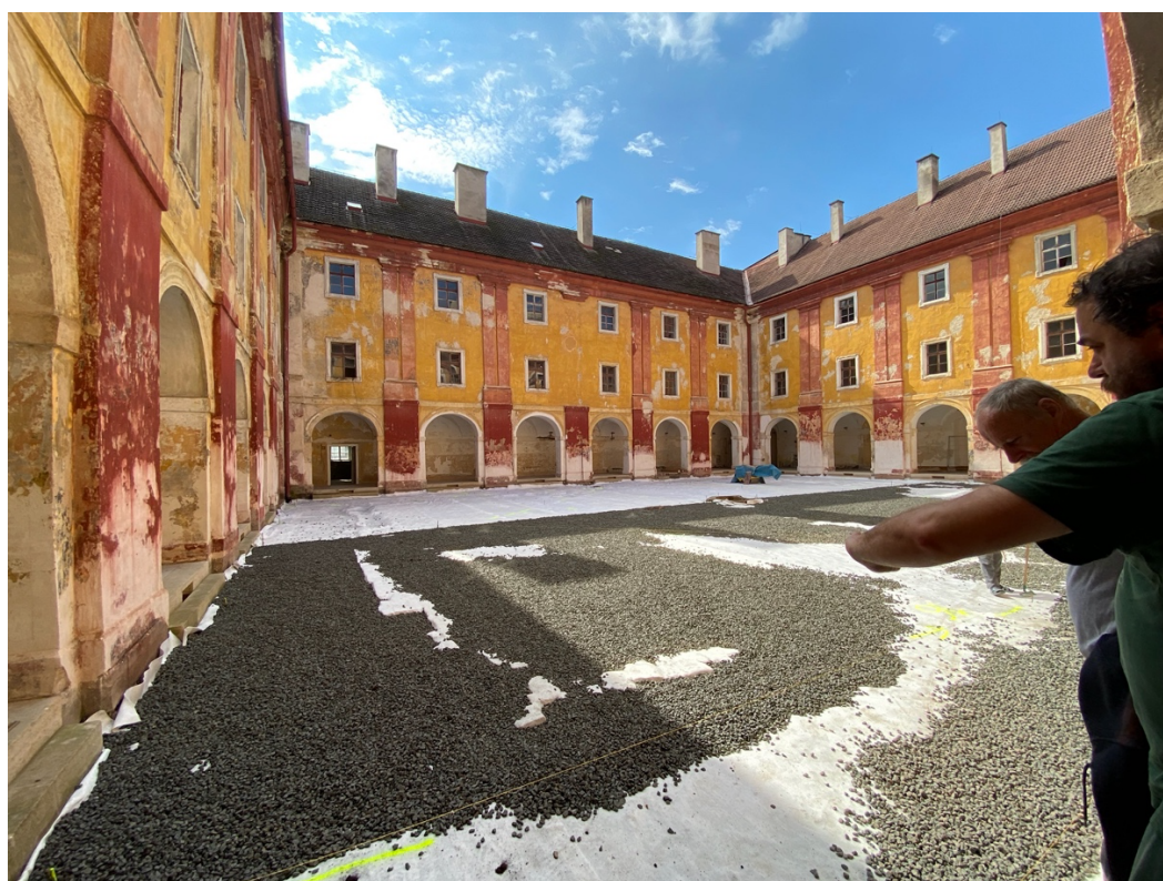
Obrázek 16, Kolej těsně před dokončením rekonstrukce, léto 2021
