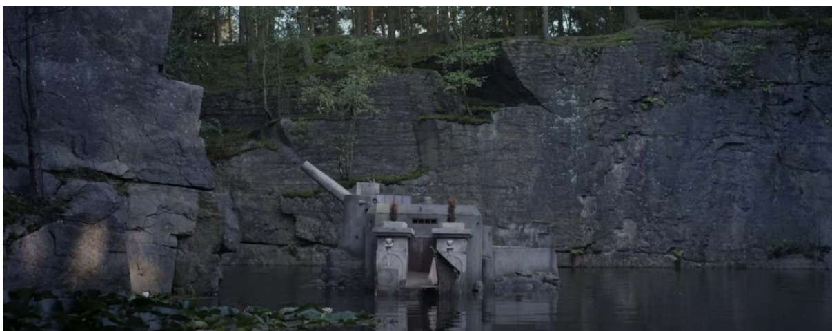
Obr. č. 3 Zámek Velké tísně zasazený v lesním jezírku
