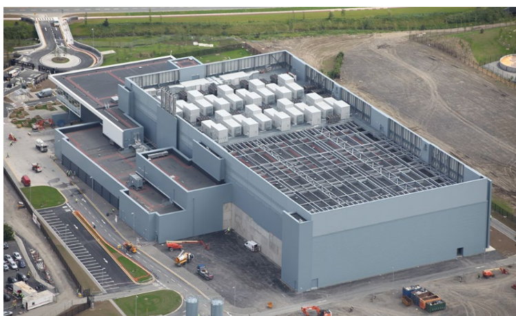
Nahoře: datové centrum NSA v Bluffdale, dole: UtahLakeside Technology Center, Chicago, Spojené Státy. 46
