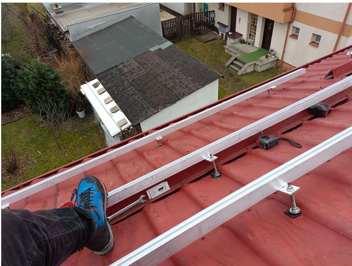
Obr. č. 4.: Vlastní fotografie – Práce na fotovoltaické elektrárně a strach z výšek, 2023.
