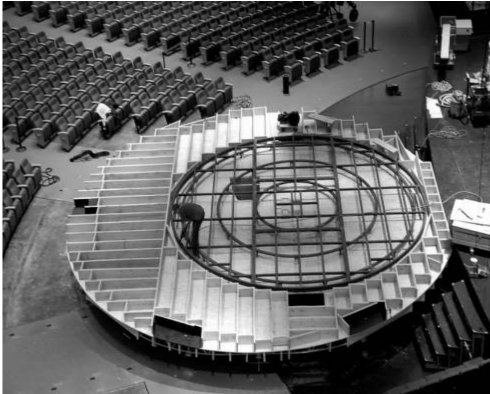
36 – Točna (odkrytá konstrukce)
