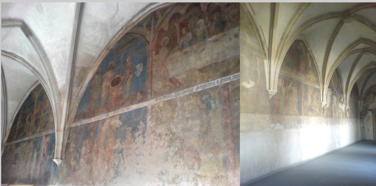
Obr. 1.3: Emauzský cyklus - gotické nástěnné malby v křížové chodbě kláštera Na Slovanech
