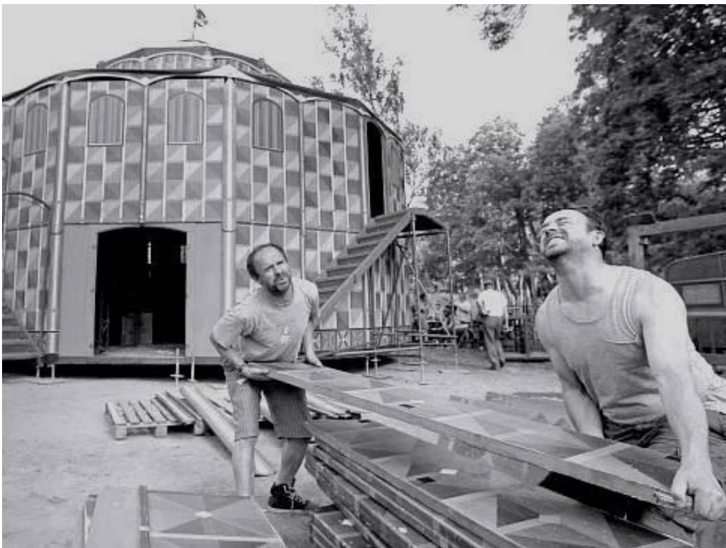
Stavba šapito vzniklého pro představení Obludárium ( foto: Libor Plíhal, www.denik.cz )
